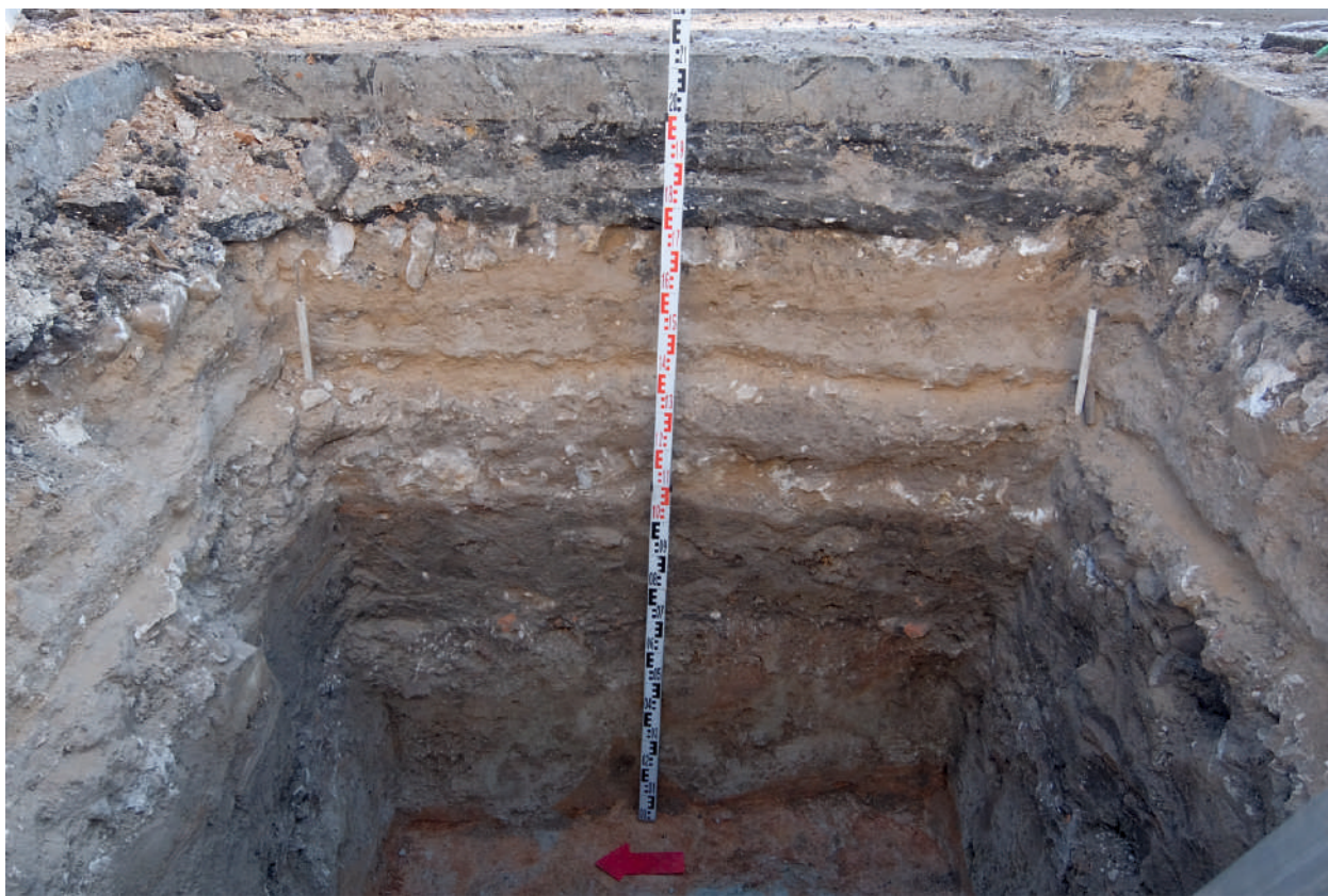
Рис. 25. Работы по проекту: «Строительство объекта «Здание гостиницы» (кадастровый номер 52:40:0301005:68). Нижегородская область. 2024 г. Участок ул. Советская. Раскоп К-12. В борт. Вид с З. Из отчета О.Ф. Бытковского 2021 г.
